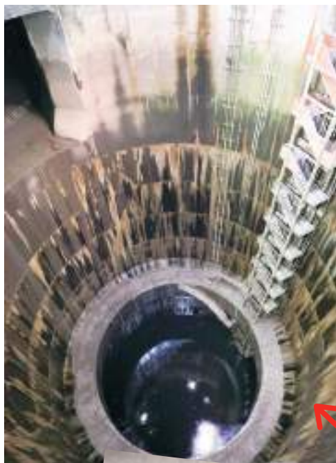
▲第1立坑の内部を見下ろす
